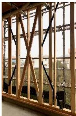
上階の揺れを抑制する目的で1階に設置された制震ダンパー
